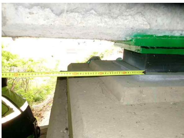
받침장치 연단거리 측정
